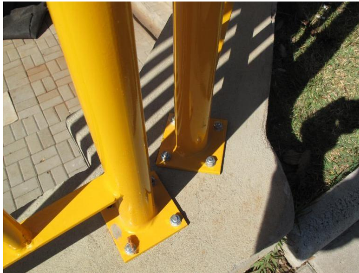
Imagem 01: detalhe da fixação dos guarda-corpos
